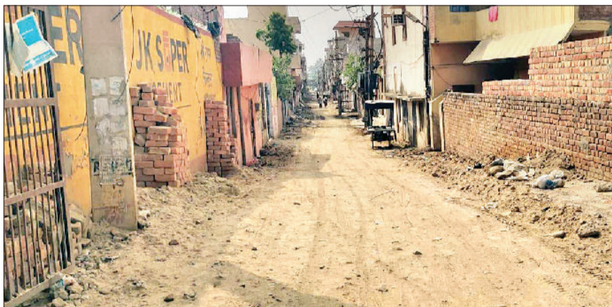
रोहतक। पाइल लाइन दबाने के लिए तोड़ी गई सड़क।
